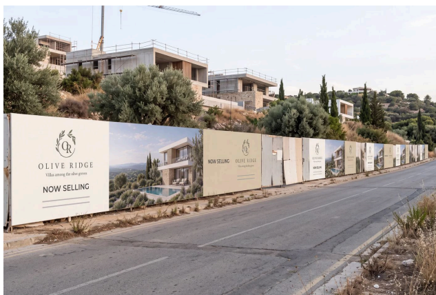
Concept de lancement Maverick Frame pour un domaine de villas : palissade de chantier avec la campagne de lancement.
